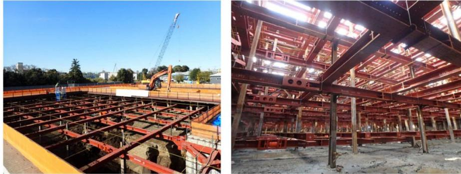
作業台(栈橋)の設置が完了し、これから深さ約24メートルまで土留支保工を7段設置しながら掘削していきます。
